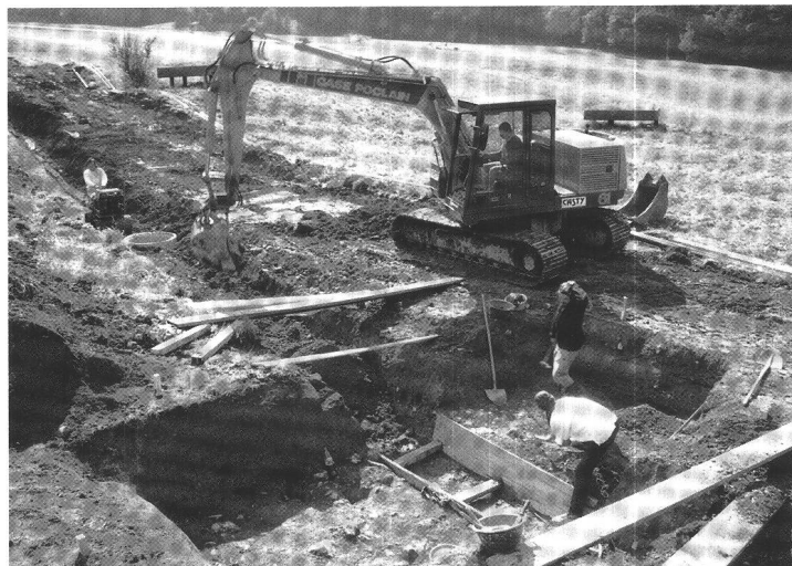
Abb. 3 Fläsch, Luzisteig-Answisen. Leitungsgraben von Norden; in der Bildmitte: Spriessung der Grabenwände bei der kohligen Grube. Foto AD GR. Fläsch, Luzisteig-Answisen. La tran- chée de la canalisation vue du nord. Au centre de l'image, l'étayage des parois à proximité de la fosse char- bonneuse. Fläsch, Luzisteig-Answisen. Canalizzazione da nord; al centro: armatura delle pareti della fossa carboniosa.
