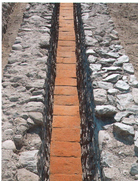
fig. 13 Égout central avec son fond dallé de tuiles. Photo Fibbi-Aeppli, Grandson. Aus Ziegeln zusammengefügte Hauptkanalisation. Canale centrale con fondo pavimentato da tegole.
