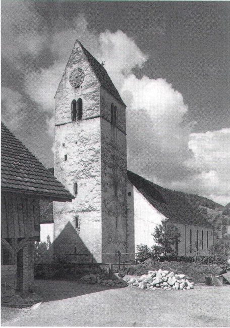
Abb. 1 Die alte Kirche von Büsserach vor dem Abbruch des Kirchenschiffs im Sommer 1951 (Foto Kantonale Denkmalpflege, Solothurn). La vieille église de Büsserach avant la démolition de la nef en été 1951. La chiesa antica di Büsserach prima del crollo della navata nell'estate del 1951.
