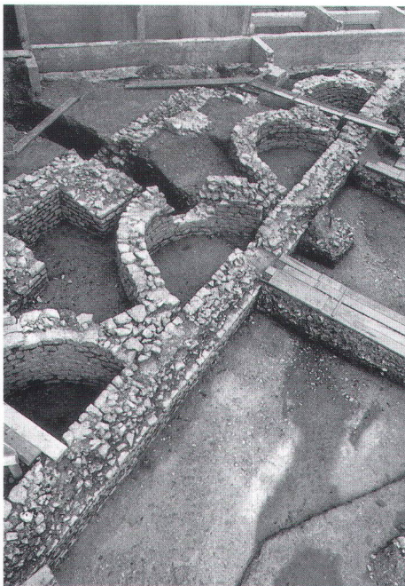
Abb. 3 Blick von Süden auf das System der zwei parallel verlaufenden Hangstützmauern. Gut zu erkennen ist links die ältere Mauer mit den vorspringenden Strebepfeilern sowie rechts davon die später vorgeblendete Stützmauer mit halbrunden Entlastungsbögen. Der zu stützende Abhang hat sich in römischer Zeit links der älteren Mauer befunden. Im Hintergrund das 1953 errichtete Kiessilo. Photo C. Alder.
