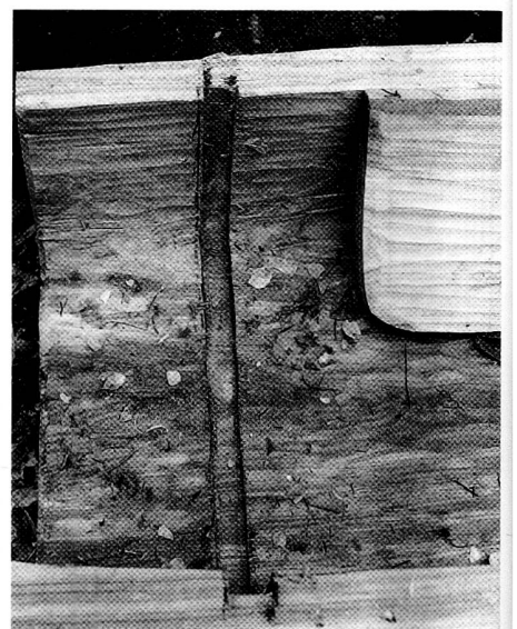
Abb. 8 Eine Nut in Wänden und Boden nimmt das Heckbrett auf. La planche faisant office de siège vient se caler dans les entailles prévues à cet effet. In una tacca sulle pareti e sul fondo dell'imbarcazione viene fissato lo specchio di poppa.
