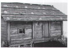
Abb. 3 Blockbau- (oben) und Bohlenständerbaumodell (unten). Rekonstruktion H. Gollnisch. Ausführung Architekturbüro Gnädinger St.Gallen, Fotos AATG, D Steiner Schéma de construction d'une maison en rondins (en haut) et en planches (en bas). Costruzione a tronchi (in alto) e ad assi infisse (in basso).
