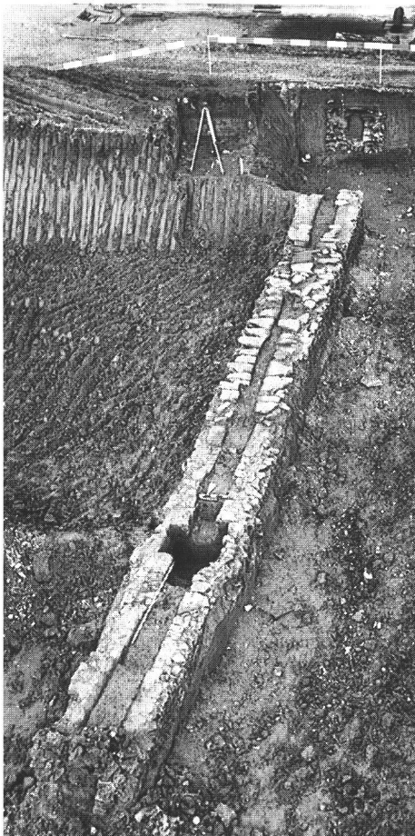
Abb. 10 Blick auf einen freigelegten Abschnitt der toten, sogenannten »älteren« römischen Wasserleitung vom Birrfeld nach Vindonissa mit eingebautem Einstieg- und Reinigungsschacht. Mise au jour d'un tronçon de l'adduction d'eau romaine détruite entre Birrfeld et Vindonissa; il est doté d'un regard intégré. Vista di un tratto del condotto romano non funzionante (che decorre tra Birrfeld e Vindonissa) con pozzetto di accesso e pulizia incorporato.
