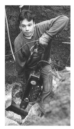
Abb 18 Untersuchung der wasserführenden römischen Wasserleitung mit dem Kanalisationsfernsehen. Examen de la canalisation romaine à l'aide d'une caméra Studio del condotto d'acqua romano per mezzo di una tele-
