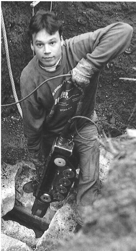
Abb. 18 Untersuchung der wasserführenden römischen Wasserleitung mit dem Kanalisationsfernsehen. Examen de la canalisation romaine à l'aide d'une caméra vidéo. Studio del condotto d'acqua romano per mezzo di una telecamera.
