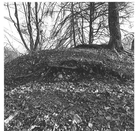
Abb. 5 Der heutige Fusspfad verletzt den oberen Teil des Walkkörpers (Abb. 6,4). Im »Profil« erkennt man gebrochenes und gelesenes Steinmaterial der Trockenmauer. Foto B. Redha. Le chemin pédestre actuel empiète sur la partie supérieure du rempart (fig. 6,4). Il est possible de reconnaître des pierres brisées et ramassées appartenant au mur en pierres sèches. Il sentiero odierno ha intaccato la parte superiore del terrapieno (fig. 6,4). La sezione longitudinale mostra materiale litico frammentato del muro a secco.
