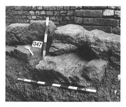
Abb. 2 Augst BL, Augusta Raurica. Moderne Ingenieurtechnik - ein Glasfaser-Maueranker - wird in einer Kalksteinmuffe versenkt und später mit kleinen Quadern »versteckt«. Foto Augusta Raurica, Ines Horisberger.
