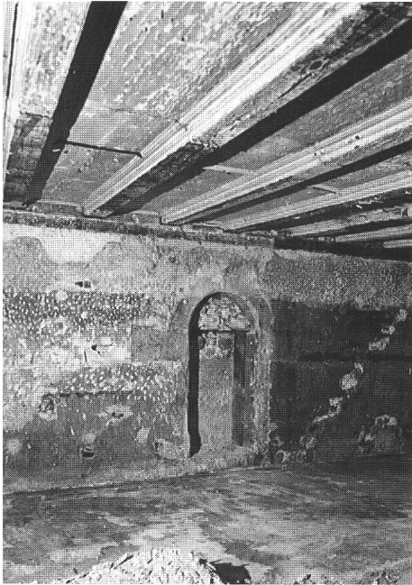
Abb. 12 Neumarkt 3, »Deutsche Schule«. In der Ostwand des gassenseitigen Kernbaus aus der ersten Hälfte des 13. Jahrhunderts hat sich der spätromanische Hocheingang hinter neuzeitlichem Täfer erhalten. Neumarkt 3, »Deutsche Schule«, avec porte d'étage tardo-romane. Neumarkt 3, »Deutsche Schule«, con ingresso alto tardoromanico.
