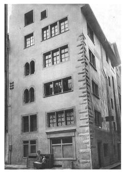
Abb. 12 Neumarkt 3, »Deutsche Schule«. In der Ostwand des gassenseitigen Kernbaus aus der ersten Hälfte des 13. Jahrhunderts hat sich der spätromanische Hocheingang hinter neuzeitlichem Täfer erhalten.
