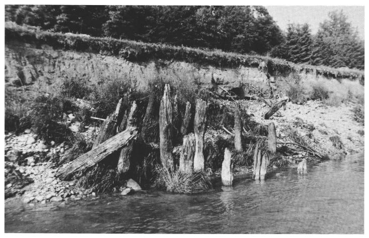
Abb. 5 Bussnang. Der von der Thur freigespülte römische Brückenpfeiler. Bussnang. La pile romaine dégagée par les eaux de la Thur.
