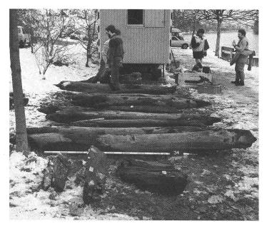
Abb. 3 Ausgezogene Brückenpfähle der Zurzacher Rheinbrücken. Pieux arrachés des ponts de Zurzach. Pali dei ponti di Zurzach.
