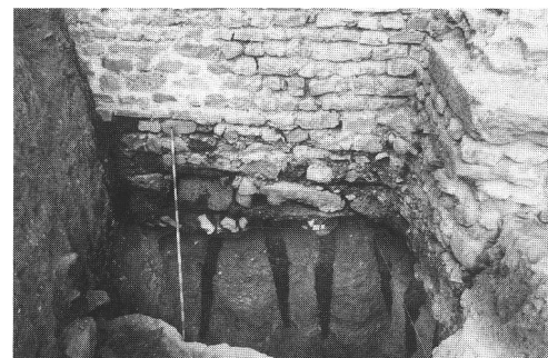
Pieux de chêne supportant les fondations d'une des tours et du rempart attenant. (Photo IAHA.)
