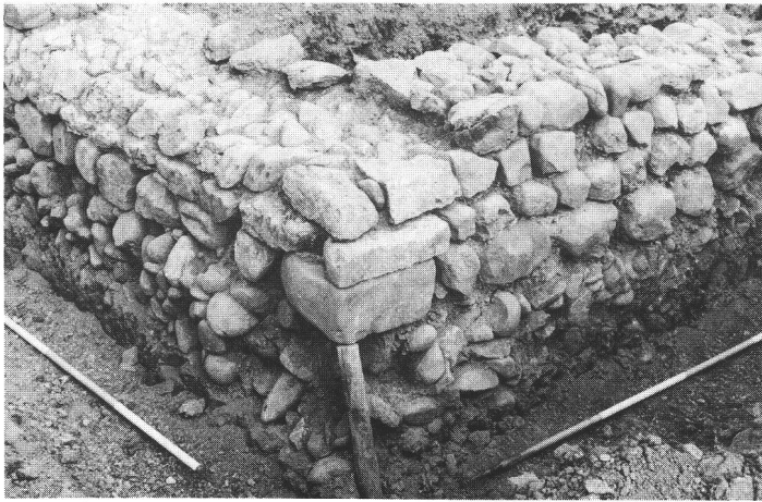
Abb. 3 Wohnhaus (Gebäude 1). Südwestliche Mauerecke mit Sickerstückung, zwei Lagen der Grundmauer und ein bis zwei Lagen des aufgehenden, schmälere Mauerwerks. Die unterste Lage des aufgehenden Mauerwerks ist abgeschrägt. Résidence principale (bâtiment 1). Mur Sud-Ouest. Casa d'abitazione (edificio 1). Muro sudovest.
