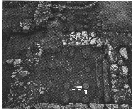
Möhlin, Nieder-Riburg: Die nachträglich eingebaute Hypokaustanlage im Mitteltrakt.
