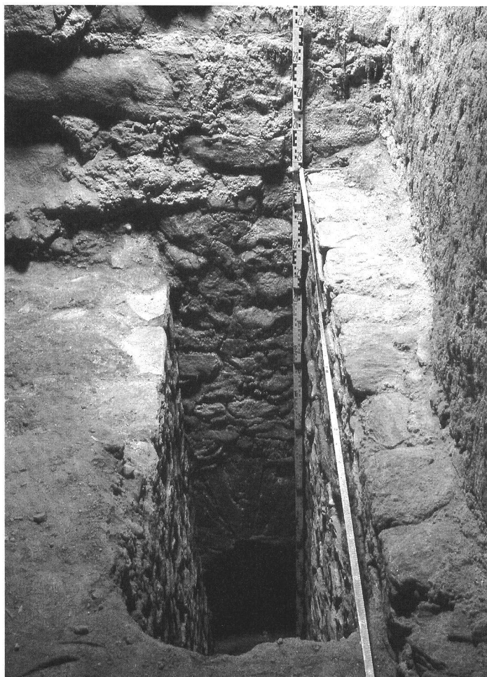
fig. 2 Sondage complémentaire, Grand'rue 27. Les fondations du cryptoportique sous les murs de la maison actuelle. Blick auf die Sondiergrabung Grand'rue 27. Unter dem heutigen Haus erkennt man die Fundamente der Kryptoporticus. Vista sul sondaggio Grand'rue 27. Sotto la casa attuale si riconosce le fondamenta del Criptoportico.
