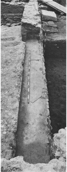
fig. 7 Insula 6. La planie en mortier sur laquelle reposait(ent) la ou les poutre(s) du seuil aménagé entre le grand dépôt et la cour attenante, vue du sud-est. On remarque bien l'encastrement de la poutre dans la maçonnerie du piédroit. Insula 6. Abdruck des grossen Schwellbalkens zwischen grosser Halle und Hof. Insula 6. Impronta della grande soglia tra sala e
