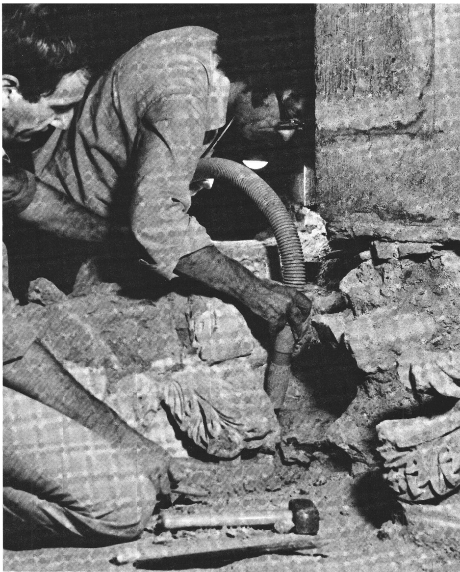
fig. 22 Dégagement de blocs remployés dans les fondations de la cathédrale actuelle. Freilegen von in den Fundamenten der heutigen Kathedrale eingebauten Spolien. Scavamento di blocchi riutilizzati nelle fondazioni della cattedrale attuale.
