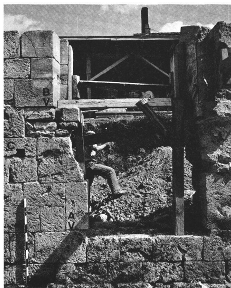
Abb. 2 Blick von Norden auf die in den Ostarm des Kreuzgangs führende südseitige Chortüre der ersten und auf die der zweiten Kirche. – A Schwellenniveau der romanischen Tür, B Schwellenniveau der spätgotischen Tür, C Gerüstbalkenloch im obersten erhaltenen Tuffquader der romanischen Mauer.
