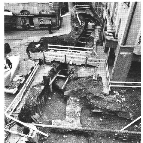
Blick auf den Hirschenplatz/Ecke Niederdorfstrasse/Brunngasse: im geöffneten Leitungsgraben ist der Fundamentwinkel eines hochmittelalterlichen Hauses zu erkennen.
