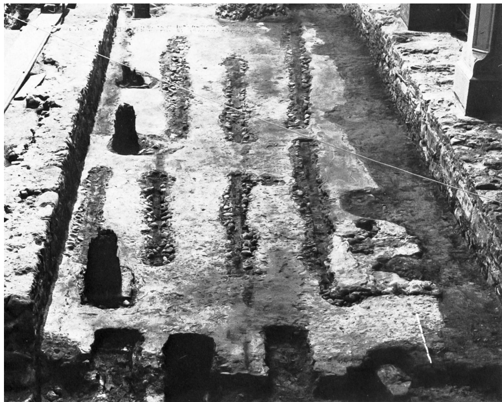
Abb. 11: St. Laurenzen in St. Gallen Mörtelboden der Kirche bis 1314. Links Reste der hölzernen Stützpfiler und auf dem Boden Ausbrüche der Balkenlager eines Holzbodens der provisorischen Kirche nach dem Brand Sol de mortier de l'église d'avant 1314. A gauche restes des piliers de bois et au sol la trace des poutres d'un plancher de bois de l'église provisoire d'après l'incendie Pavimento cementizio della chiesa prima del 1314. A sinistra resti dei pilastri di legno e, sul pavimento la traccia del legname della chiesa provvisoria dopo l'incendio
