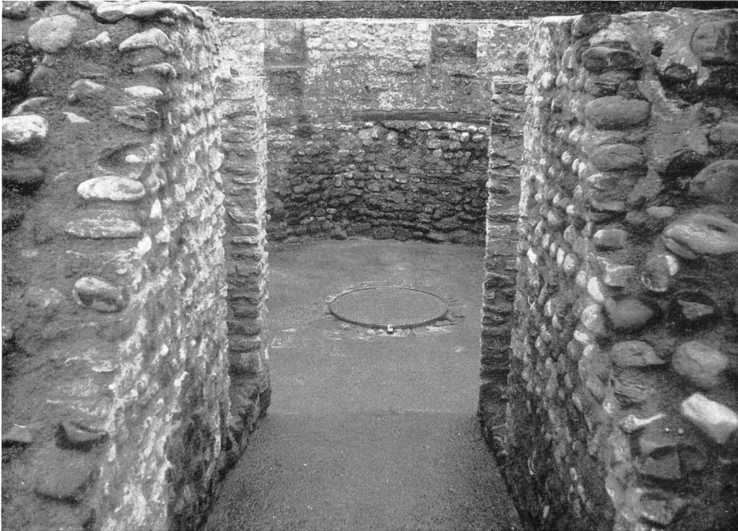
Abb. 77. Winkel ZH. Das römische Brunnenhaus bei Seeb. Nach der Konservierung im Frühjahr 1964. Blick durch die Zugangsrampe zum Sodbrunnen. Photo: Verfasser.
