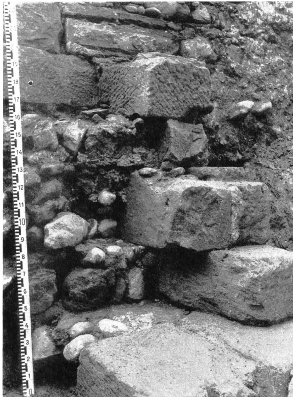
Abb. 4. Nordöstlicher Rechteckturm, im Verband mit der nördlichen Kastellmauer, von Nordost, in F XXI.
