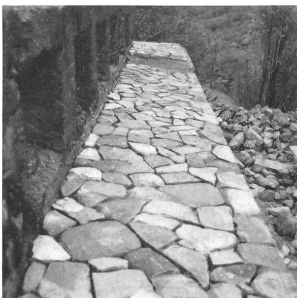
Abb. 48. Abdecken des römischen Mauerwerks mit «Plattenmosaik».
