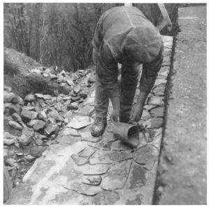
Abb. 49. Ausgießen der Fugen mit Spezialbojacke.
