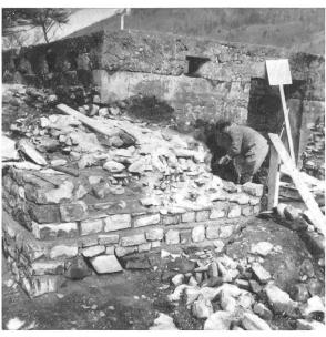
Abb. 47. Beginn der Konservierungsarbeiten: Vormauern.
