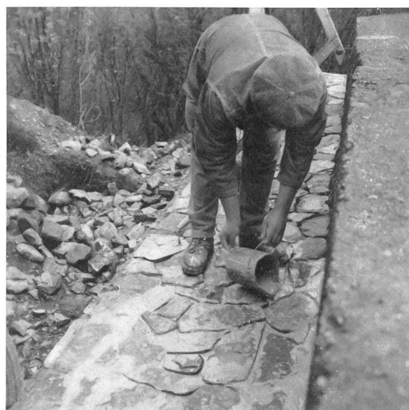
Abb. 49. Ausgießen der Fugen mit Spezialbojacke.
