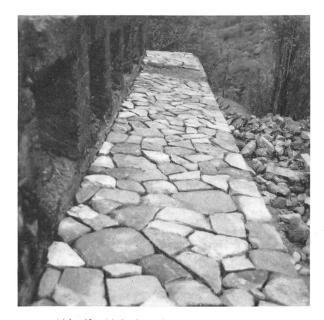
Abb. 48. Abdecken des römischen Mauerwerks mit «Plattenmosaik».
