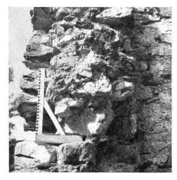
Abb. 59. Strahlegg. Querschnitt durch die Südmauer beim Eingang.
