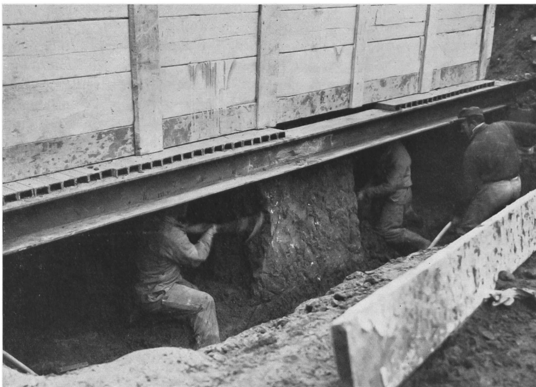
Abb. 54. Die Großgrabanlage wird mittels U-förmiger, schmaler Eisenschienen in Bergbaumanier unterfangen und anschließend auf drei Doppel-T-Eisen von je 500 kg Eigengewicht gelegt.
