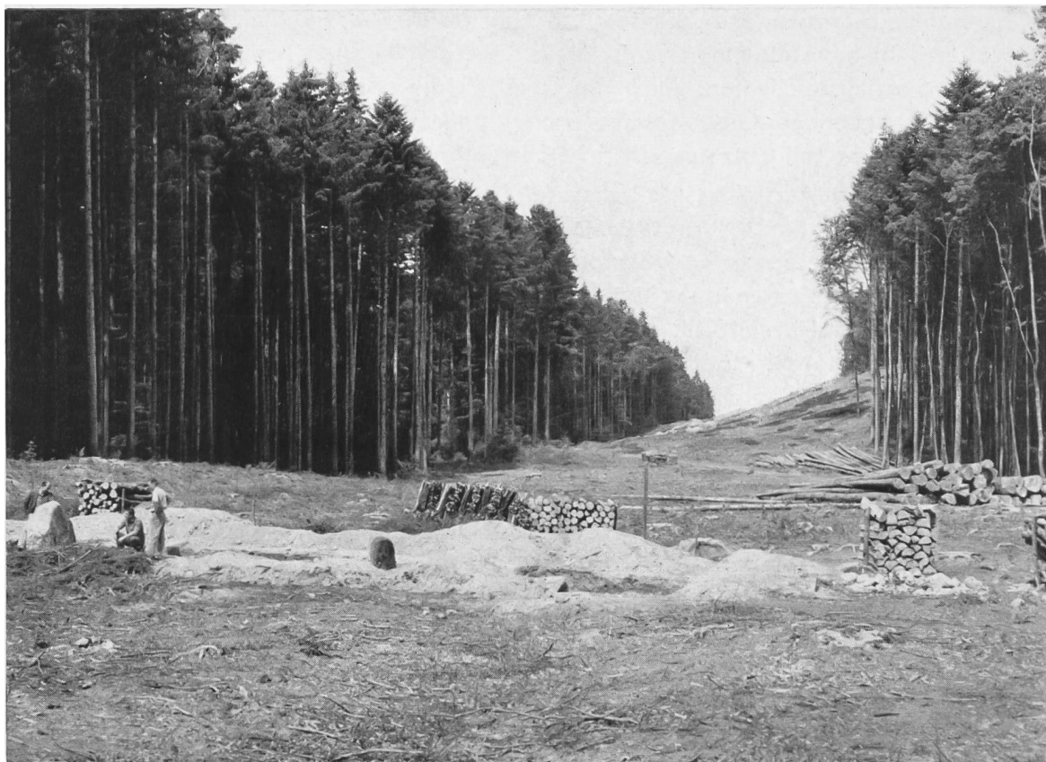
Abb. 17. Schneise durch das Grauholz bei Bern; im Vordergrund das sog. «Bottisgrab», zwei aufgerichtete Steinblöcke unbekannter Bedeutung.
