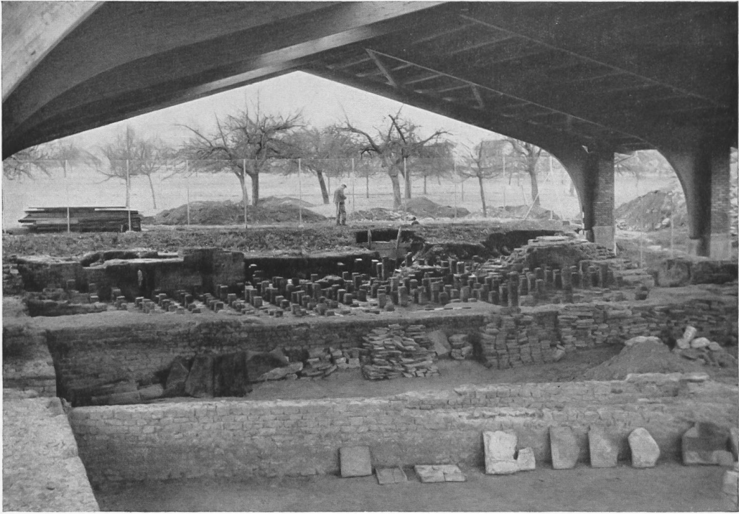
Fig. 20. Avenches, En Perruet: Tepidarium, direction ouest.
