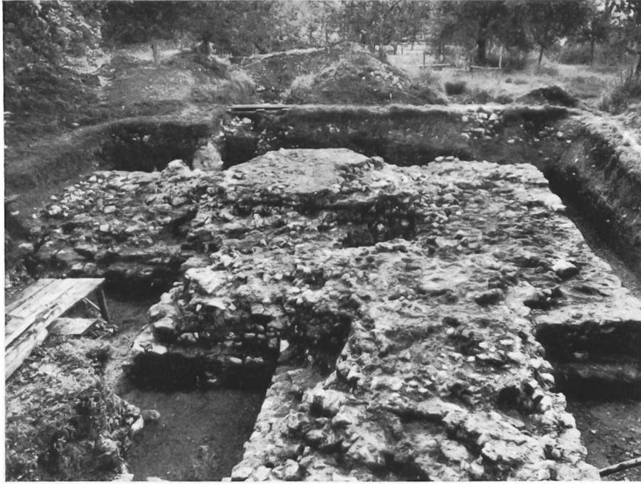
Abb. 8. Schaan, Kastell. Der Südostturm von Westen, mit der anschließenden Mauer. Photo D. Beck.
