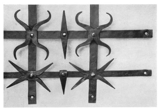
Abb. 14. Hölstein, römisches Fenstergitter. Detailaufnahme der Rekonstruktion (untere rechte Ecke). Sie zeigt deutlich die etwas grobe Schmiedetechnik und die Beschaffenheit des Materials. An einzelnen Stellen ist die Sehnigkeit des Eisens gut zu erkennen. Die ganze Arbeit wurde auf dem Amboß gemacht ohne einen einzigen Feilenstoß. Das schwedische Holzkohleneisen wurde für diese Arbeit von der Firma Vögelin und Rückert, Basel, geschenkweise überlassen.
