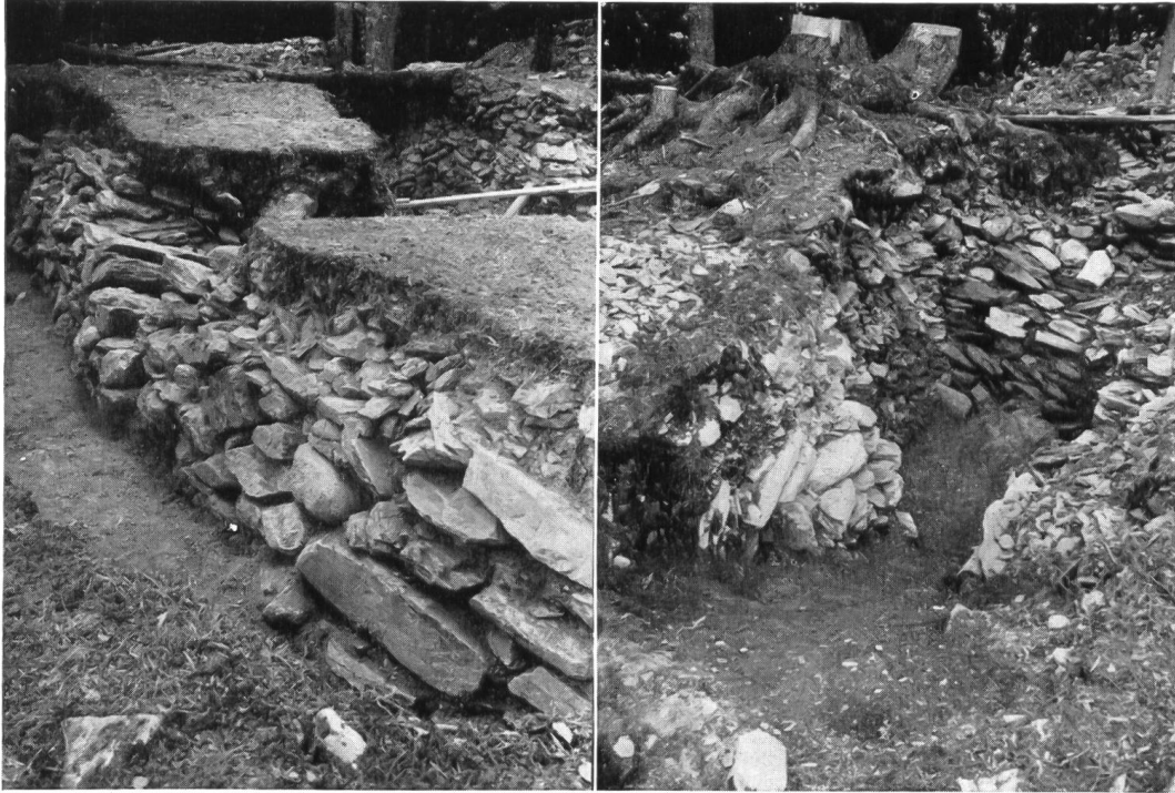
Abb. 8. Caschlins, Hauptmauer der Ostfront, äussere Ansicht.
