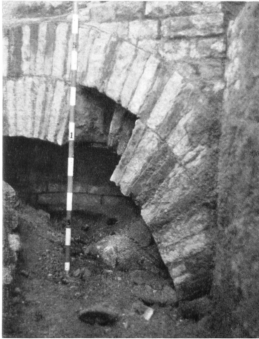
Abb. 33. Augst, Zentralthermen. Eckverstrebung im Fundament des Frigidariums.
