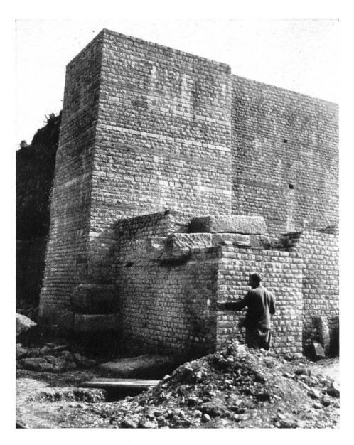
Abb. 10. Augst. Stützmauer der Basilica mit Entwässerungskanal (Cascade).
