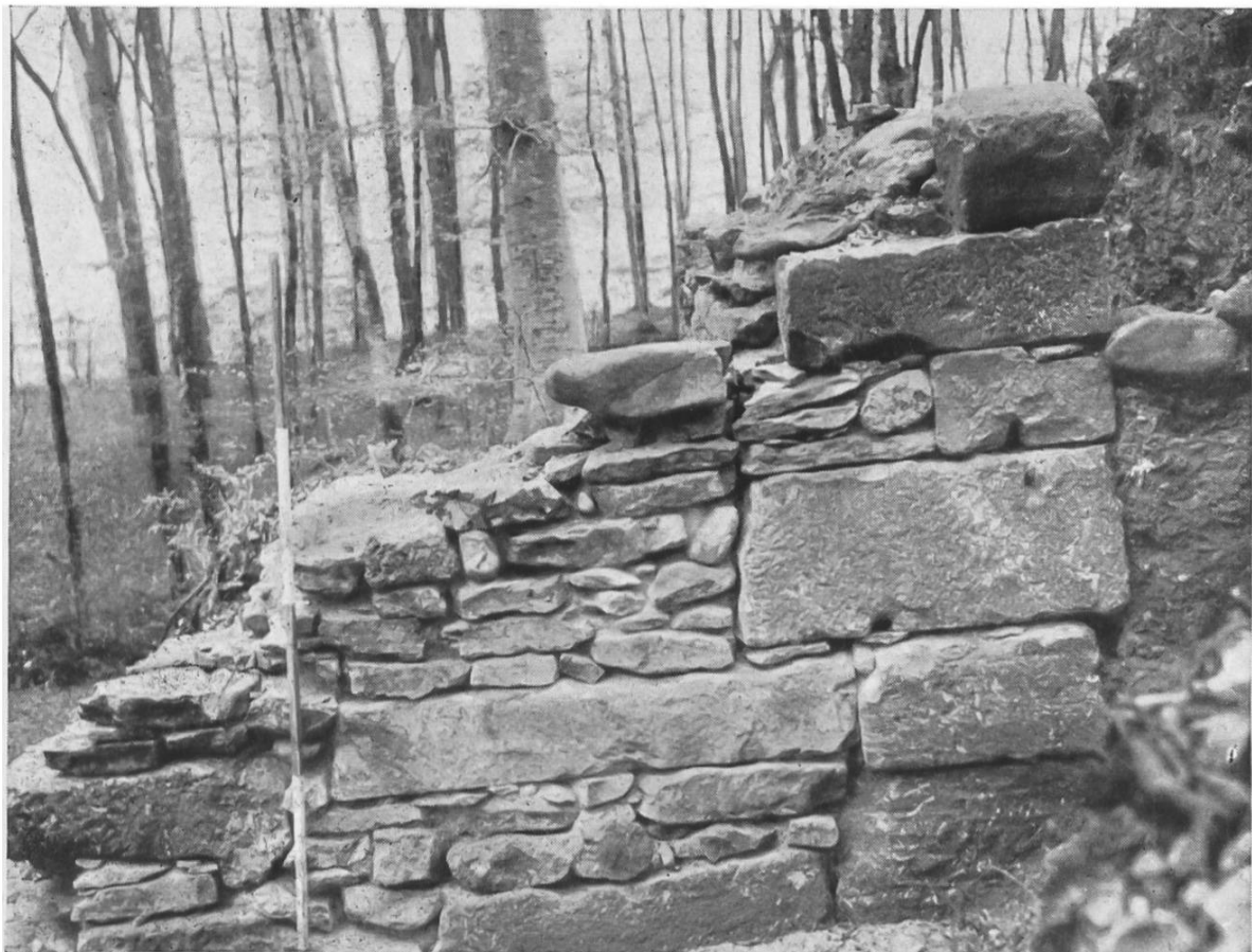
Abb. 39. Möhlin. Mauer des Torturmes aus alten Quadersteinen.
