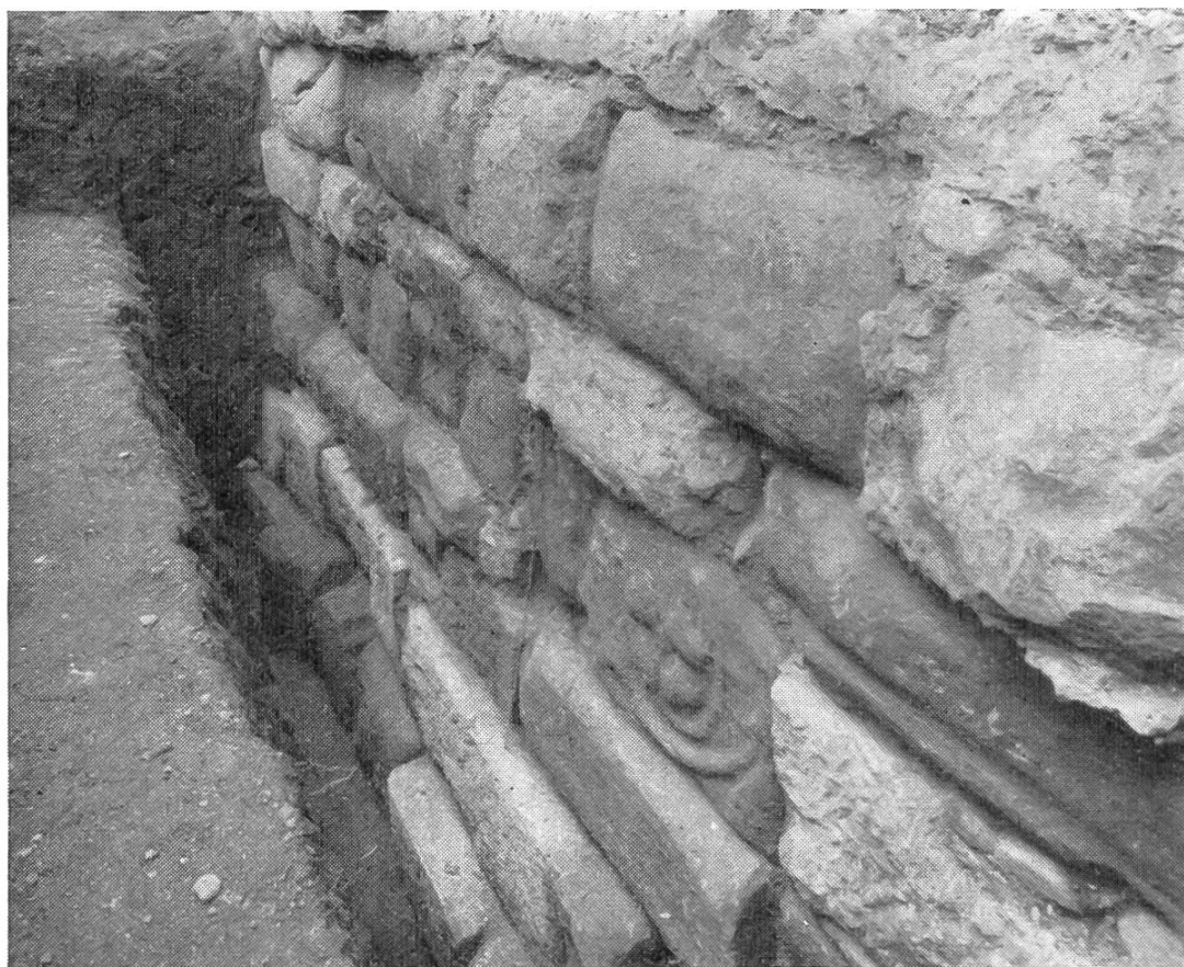
Fig. 34. Genève. Substruction du mur d'enceinte romain (III e siècle après J. C.)
