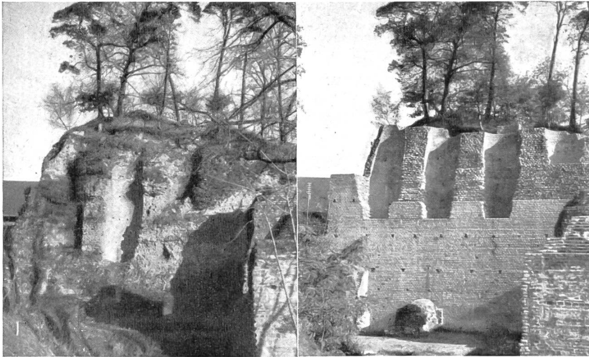
Abb. 9. Augst, Nordflügel des Theaters, vor und nach der Konservierung 1938. Die Ruine sah vorher vielleicht romantischer aus; doch sie stand im Begriff, ein Steinhaufen zu werden.
