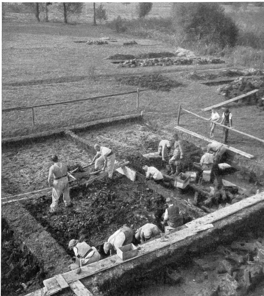
Abb. 12. Ausgrabung eines Pfahlbaus am Baldeggersee.
