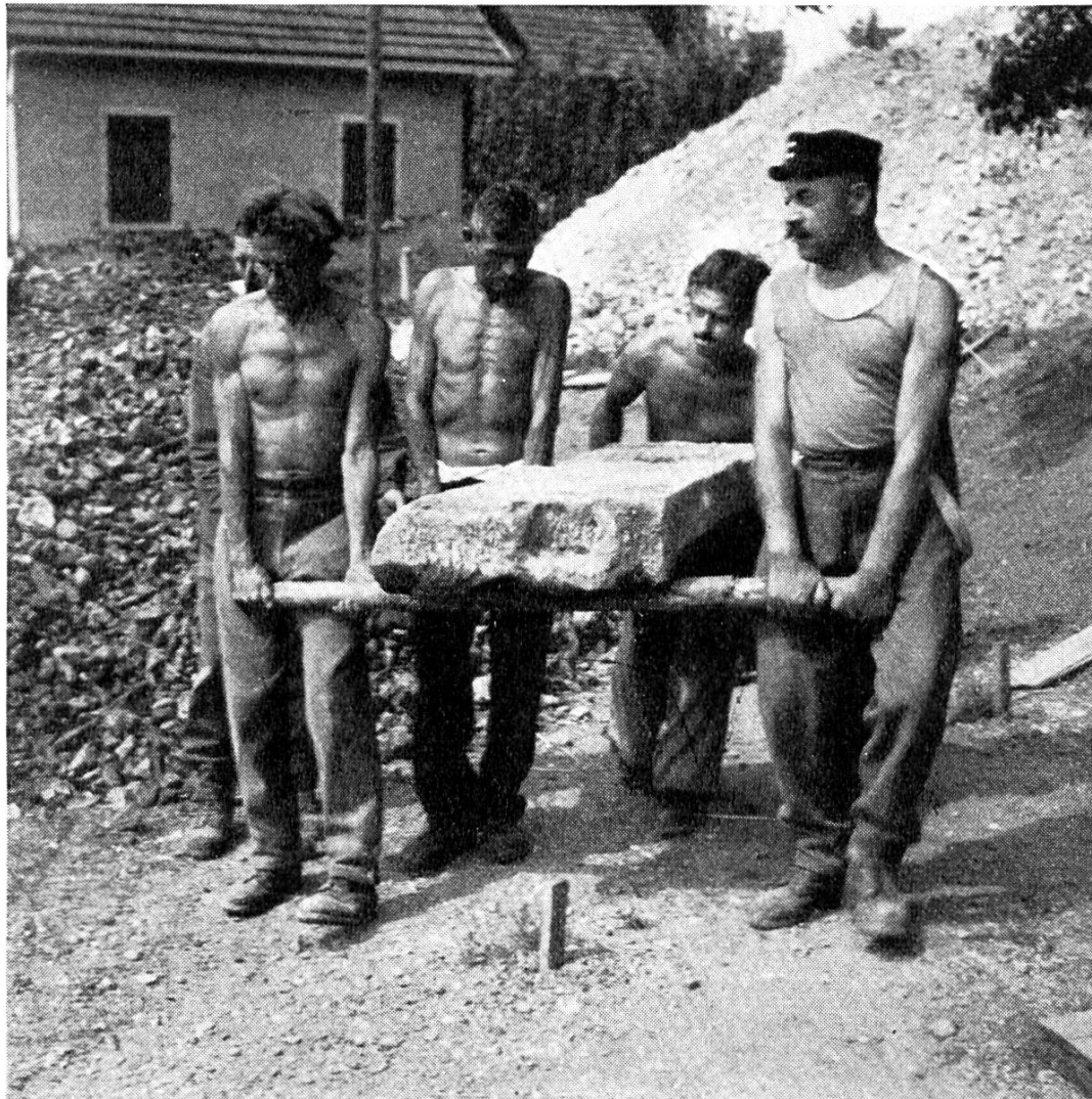
Abb. 8. Ein römischer Quader wird transportiert. (Arbeitsdienst Augst).
