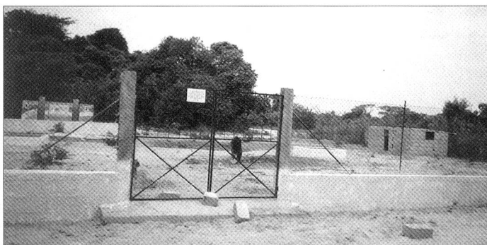
Clôture, portail et les deux bassins du jardin scolaire de l'école de Cabrousse I au Sénégal, financés par des membres et amis du groupelement genevois ARFS. Photos: Fernand Gardy
