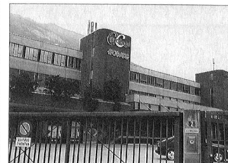
Im ehemaligen Swisscom-Gebäude am Grossbruggerweg 2 in Chur eröffnete die Prodega ein neues Einkaufsparadies. Foto: zvg
