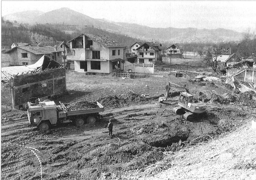
Auch die Ausgaben für Baumassnahmen laufen über die «Finanzminister». Unser Bild: Pioniere mit schwerem Gerät arbeiten an/auf der Auffahrt zur schwer beschädigten Brücke über die Bosna. Im Hintergrund die zerstörte Ortschaft Visoko, die zirka 20 Kilometer nordwestlich von Sarajewo liegt.
