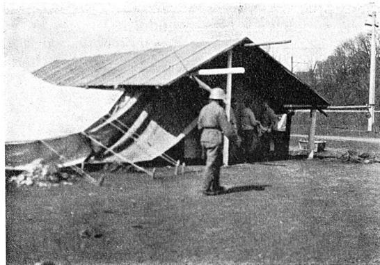
Sand, Backsteine und Dachpappe. Die Arbeitsgruppe für den Bau einer Garnitur besteht normalerweise aus einem Offizier, 4 U.-Of. und ca. 30 Soldaten. Wenn die erforderlichen Baumaterialien auf der Baustelle bereit sind, so kann eine Garnitur durch geübte Leute in 14 Stunden erstellt und zum Anheizen bereit sein.
