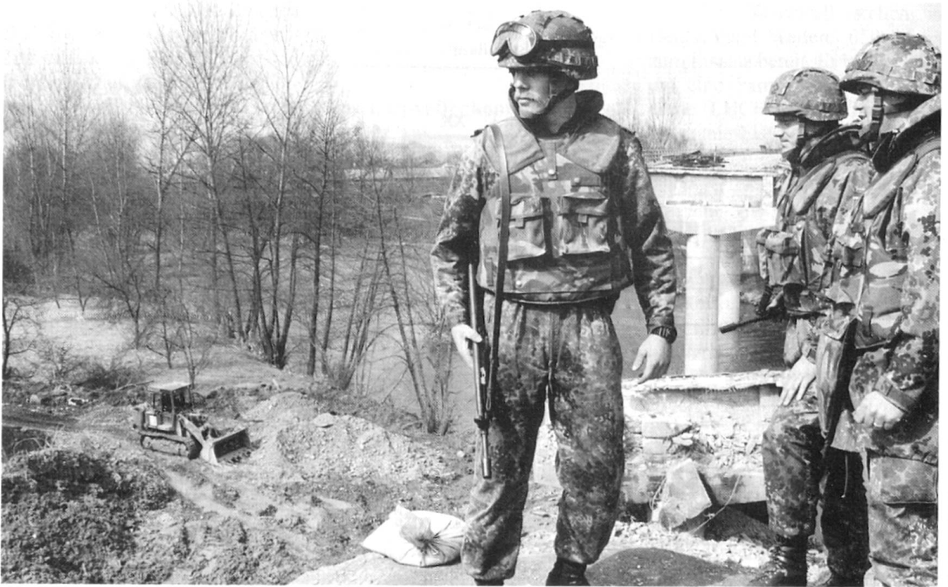
Soldaten des Pionierbataillons GECONIFOR (L) reparieren die schwer beschädigte Brücke über die Bosna bei der Ortschaft Visoko, welche rund 20 km nordwestlich von Sarajewo liegt. Im Bild: Pioniere auf der Auffahrt zur Brücke. Im Hintergrund die zerstörte Brücke.
