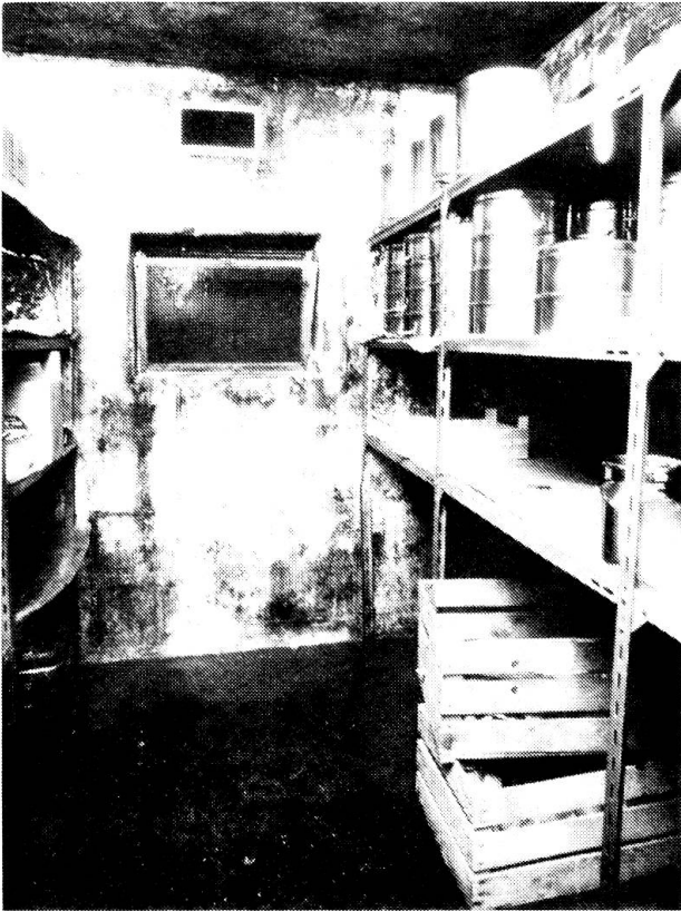
Bild oben: Mehr Feucht- als Frisch(gemüse)magazin. Zudem gehören Harassen und Kisten nicht direkt auf den Boden.
