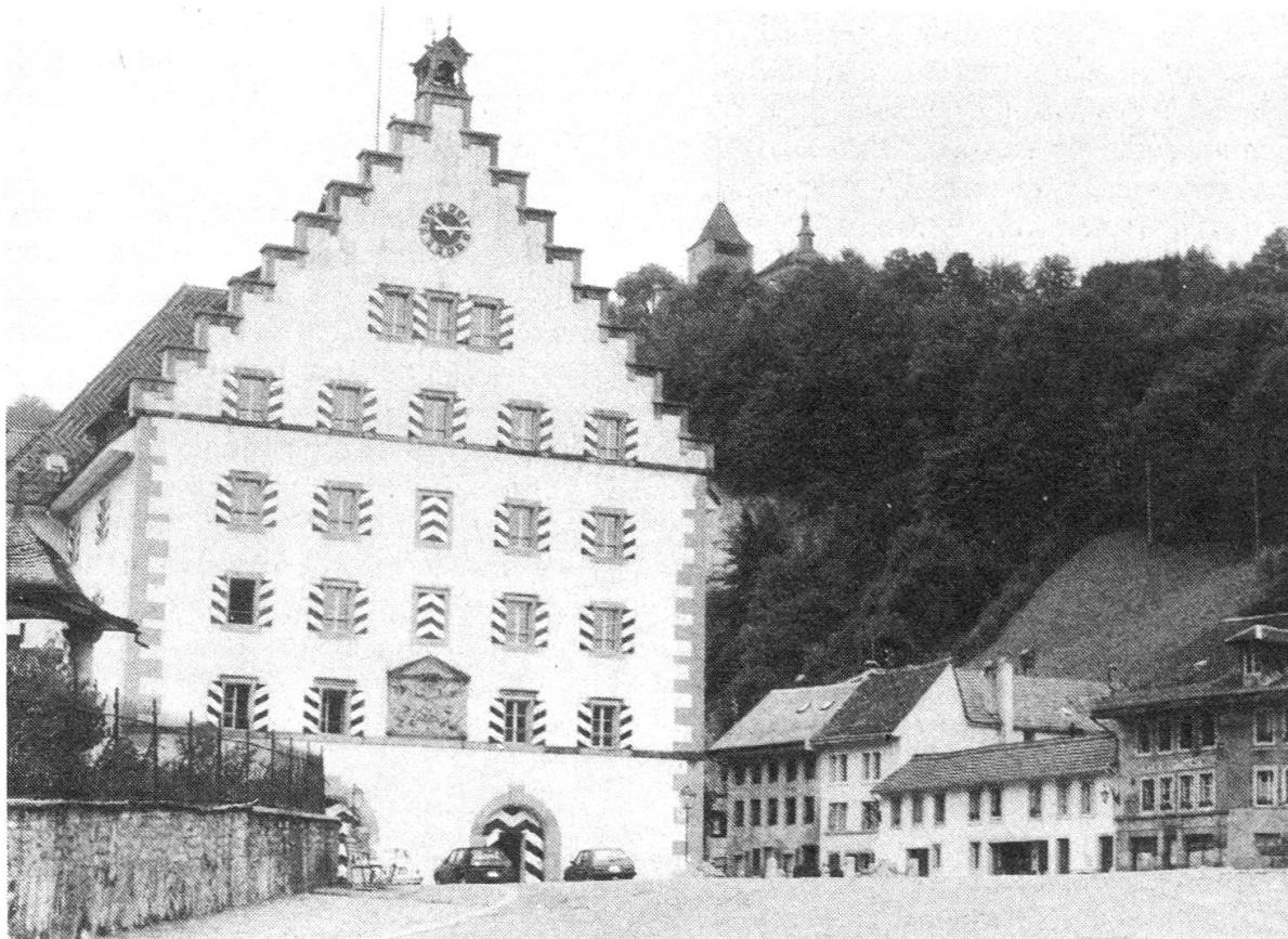
Diese Kaserne in der schön herausgeputzten Altstadt von Fribourg (es ist diejenige der Versorgungs-Truppen RS/UOS) zeigt deutlich, was aus einer ehemals verlotterten, hygienisch gar nicht über allen Zweifeln stehenden Baute gemacht werden konnte. Mit Hilfe des Heimatschutzes wurde sie renoviert und präsentiert sich sowohl innen als auch aussen mit dem gut erhaltenen Umgelände heute als markanten Mittelpunkt der Altstadt. Einziger Wermutstropfen bei dieser Bundesunterkunft: Die Ruhe wird von den Altstadtbewohnern so über alles geschätzt, dass die Armee-Motorfahrzeuge ausserhalb der Altstadt parkiert werden müssen und der morgendliche Spaziergang der Rekruten zu den Transportmitteln zum gewohnten «Dorf-Bild» gehört.
