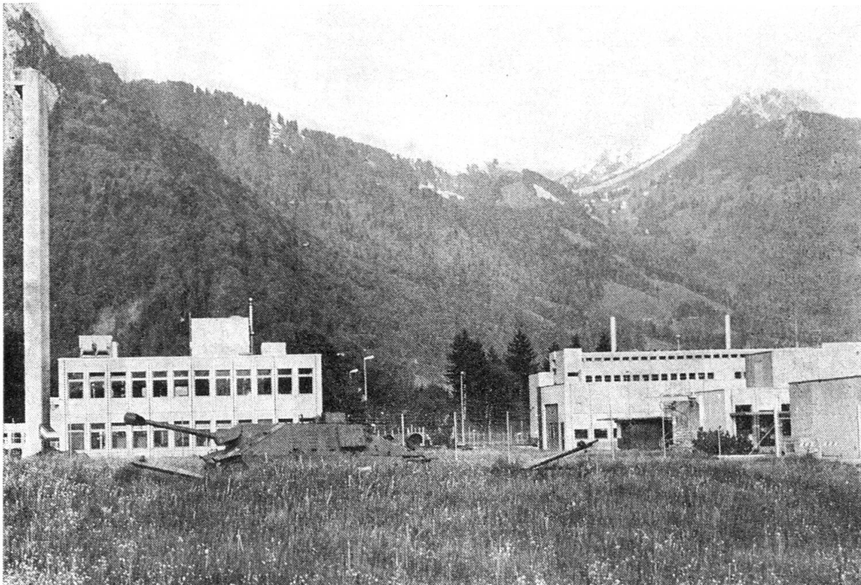
AC-Zentrum Spiez, ein 70 Millionen-Bau (Teilansicht)
