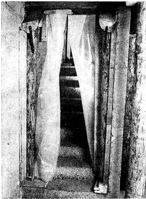
Kellereingang mit Unterstützung und Staubschleusen
