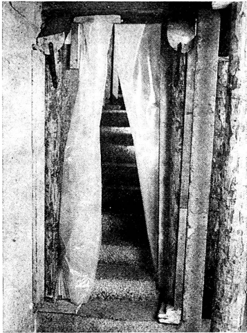
Kellereingang mit Unterstützung und Staubschleusen
