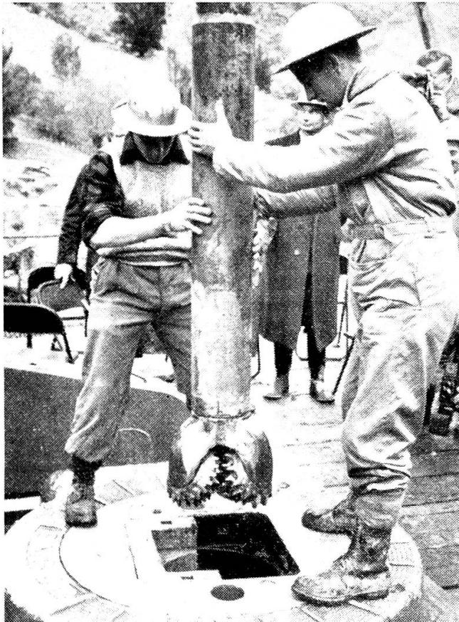
Hier wird ein Bohrmeissel durch das Loch des Bohrtisches eingeführt (Photo BP)
