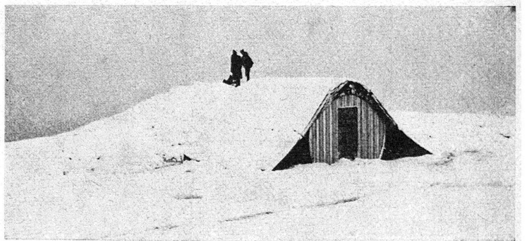
Bild 7/8: Mittels Zeltblachen lassen sich die Unterstände auf freiem, vegetationslosem und durch Flugzeuge einsichtbarem Gelände gut tarnen. Im Sommer sorgt die Tarnfarbe der Zeltblachen, im Winter der Schnee für Unsichtbarkeit aus der Luft.
