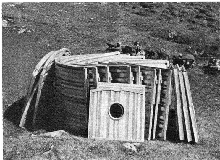
Bild 2: Bogen- und Abschlusselemente im Übungsgelände vor der Montage.
