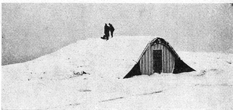
Bild 7/8: Mittels Zeltblachen lassen sich die Unterstände auf freiem, vegetationslosem und durch Flugzeuge einsichtbarem Gelände gut tarnen. Im Sommer sorgt die Tarnfarbe der Zeltblachen, im Winter der Schnee für Unsichtbarkeit aus der Luft.
