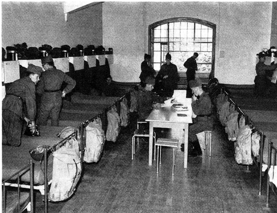
Renovierter Schlafsaal in der Kaserne Thun
