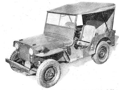
Geländepersonenwagen Jeep,  $4\times4$  (mit Vierradantrieb), Tragkraft  $^{1}/_{4}$ t
